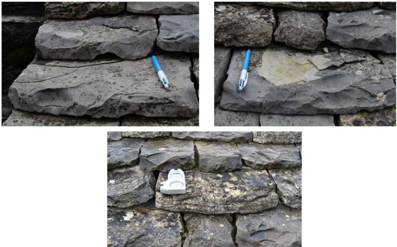
*Figure 9 dégradations des lauzes calcaires pouvant se produire*
