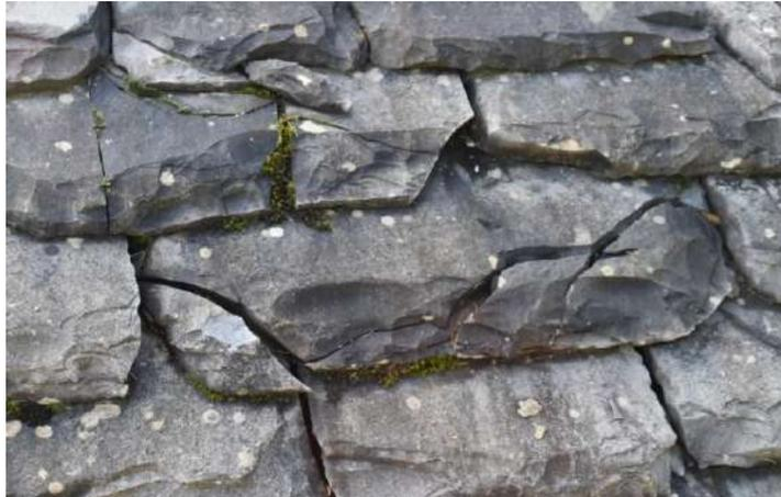
*Figure 21 lauze calcaire dégradée suivant le mode gélidisjonction*
