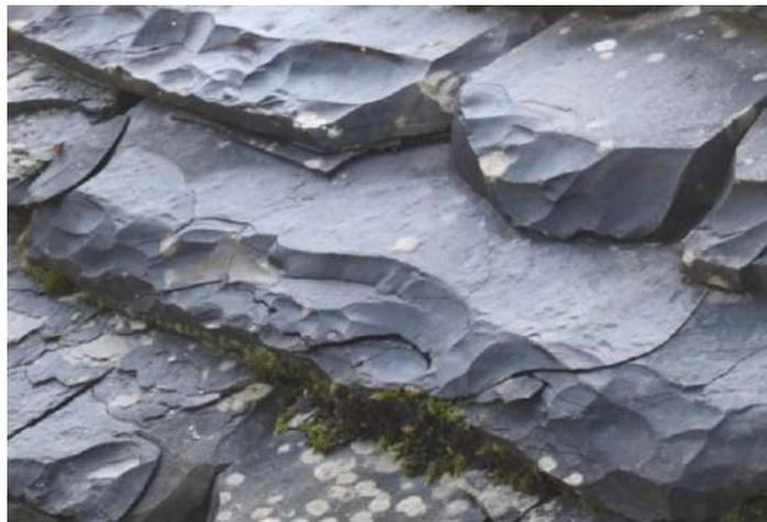
*Figure 22 lauze calcaire dégradée suivant le mode délitage*
