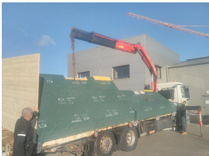
Maquette de toit destinée à recevoir des lauzes
